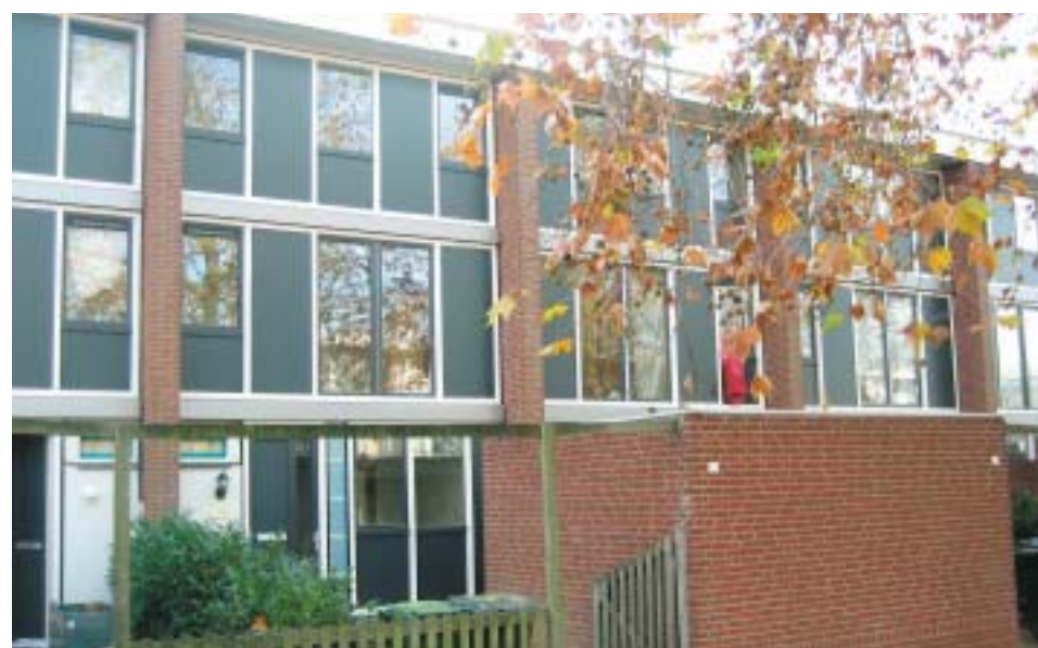
De gedeeltelijk opgeknapt voorgevel van het eerste blok Leekerhoek 7 t/m 14. De kunststof puien zijn geplaatst met hierin de panelen en beglazing. Over de panelen komt nog de gevelbekleding in een themakleur.
