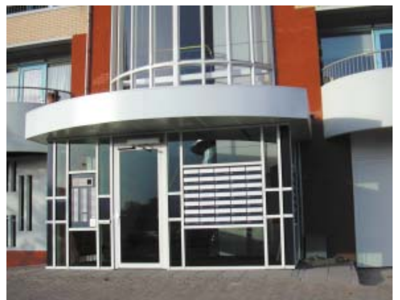
De vernieuwde entree van het Combinatiegebouw.
