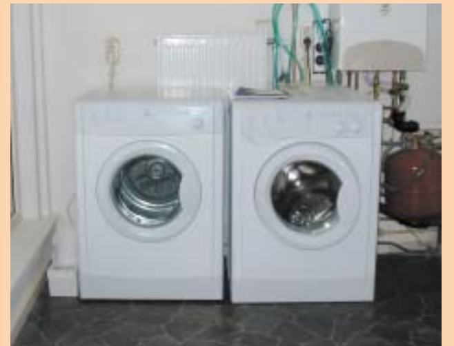
Het logeerhuis aan de Leekerhoek 10 is van alle gemakken voorzien.
